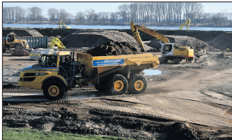
Grondwerk verricht in de Beijenwaard waar de overnachtingshaven wordt gerealiseerd.
