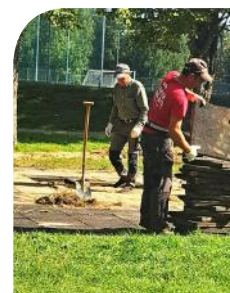
Skvere „Vaikų pasaulis“ vykdomi žaidimo įrenginių remonto darbai
