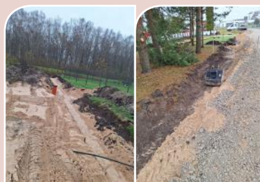
Lietaus nuotekų tinklų remonto darbai Naujosios Akmenės Gaudžiočių ir Sodo gatvėse
