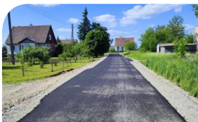
Remonto darbai Tuopų g.
