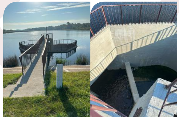
Klykolių tvenkinio HTS po remonto darbų
