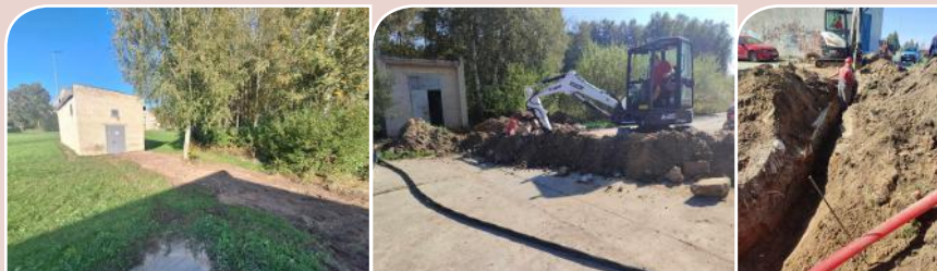
Įvadinio aukštos įtampos 10 kW elektros kabelio pakeitimo darbai siurblinėje Respublikos g. Naujojoje Akmenėje
