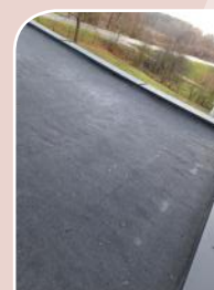
Ventos m. vandenvietės nugeležinimo pastato stogo remonto darbai
