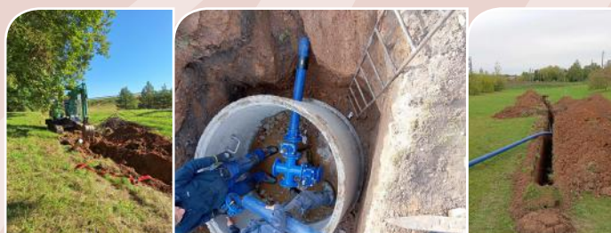
Vandentiekio tinklų įrengimas Putokšlio g. Ventos k.
