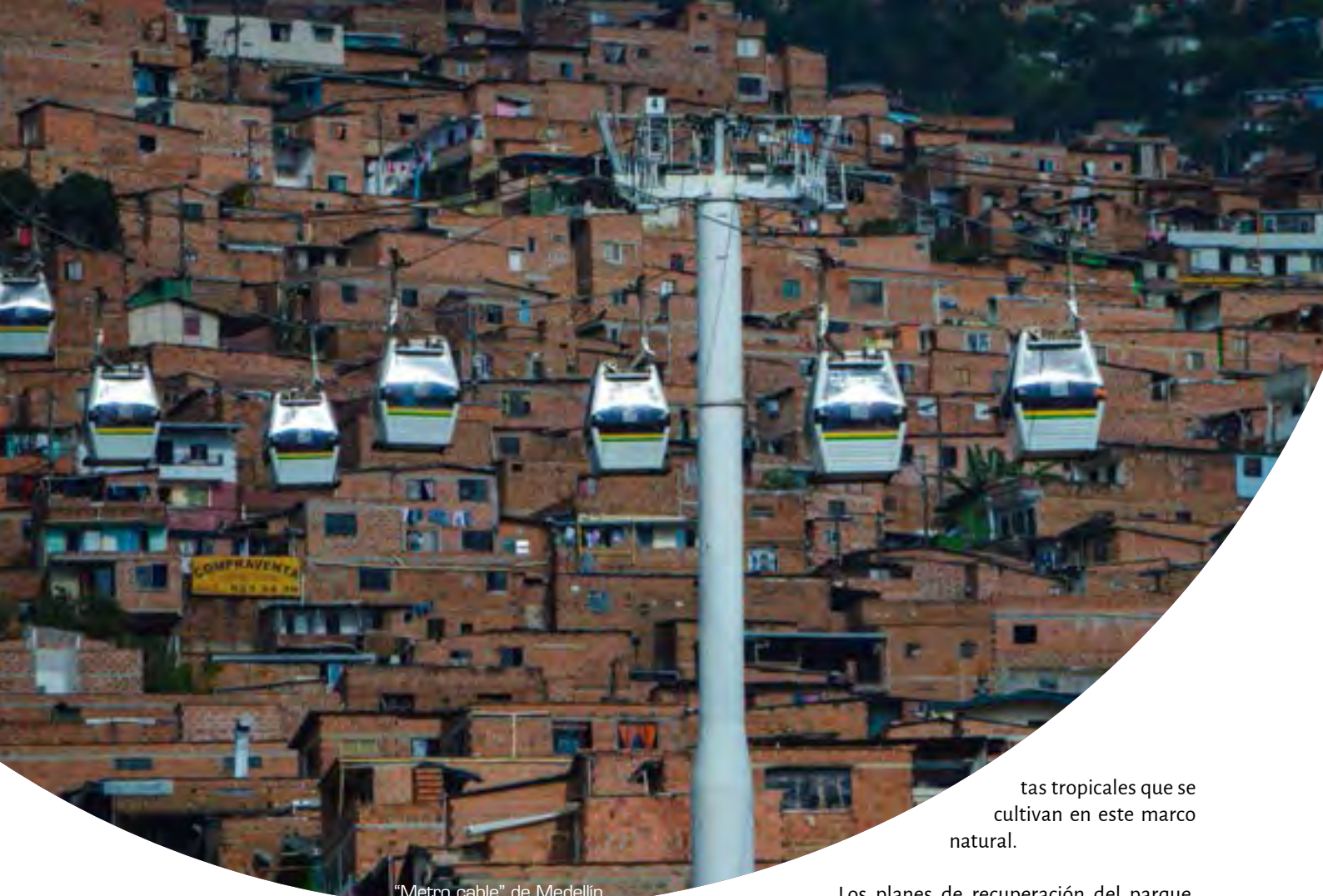
“Metro cable” de Medellín
