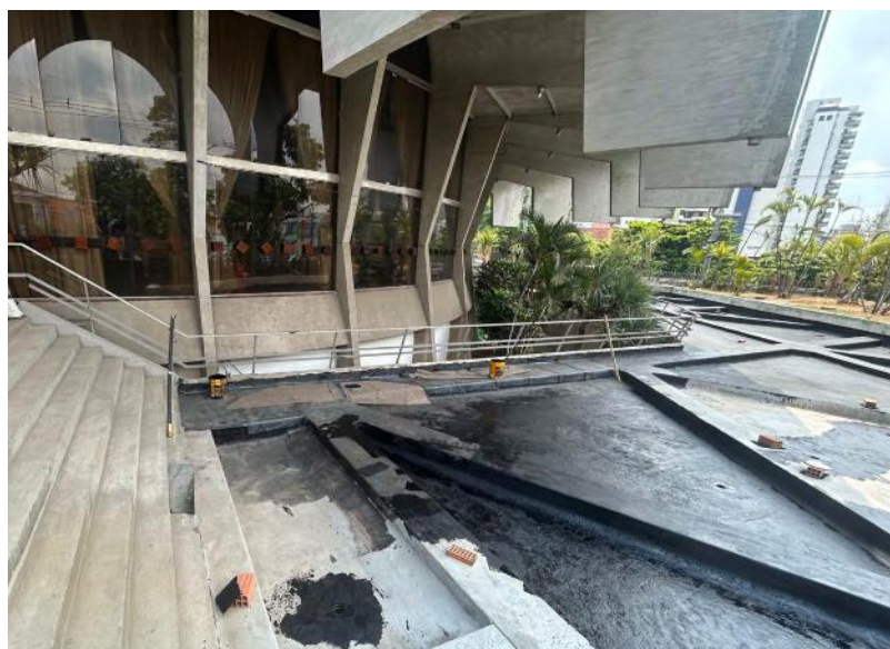
IMPERMEABILIZAÇÃO DO TERRAÇO DO SALÃO NOBRE
