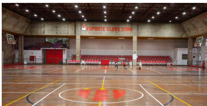
TROCA DA ILUMINAÇÃO DO GINÁSIO POLIESPORTIVO
