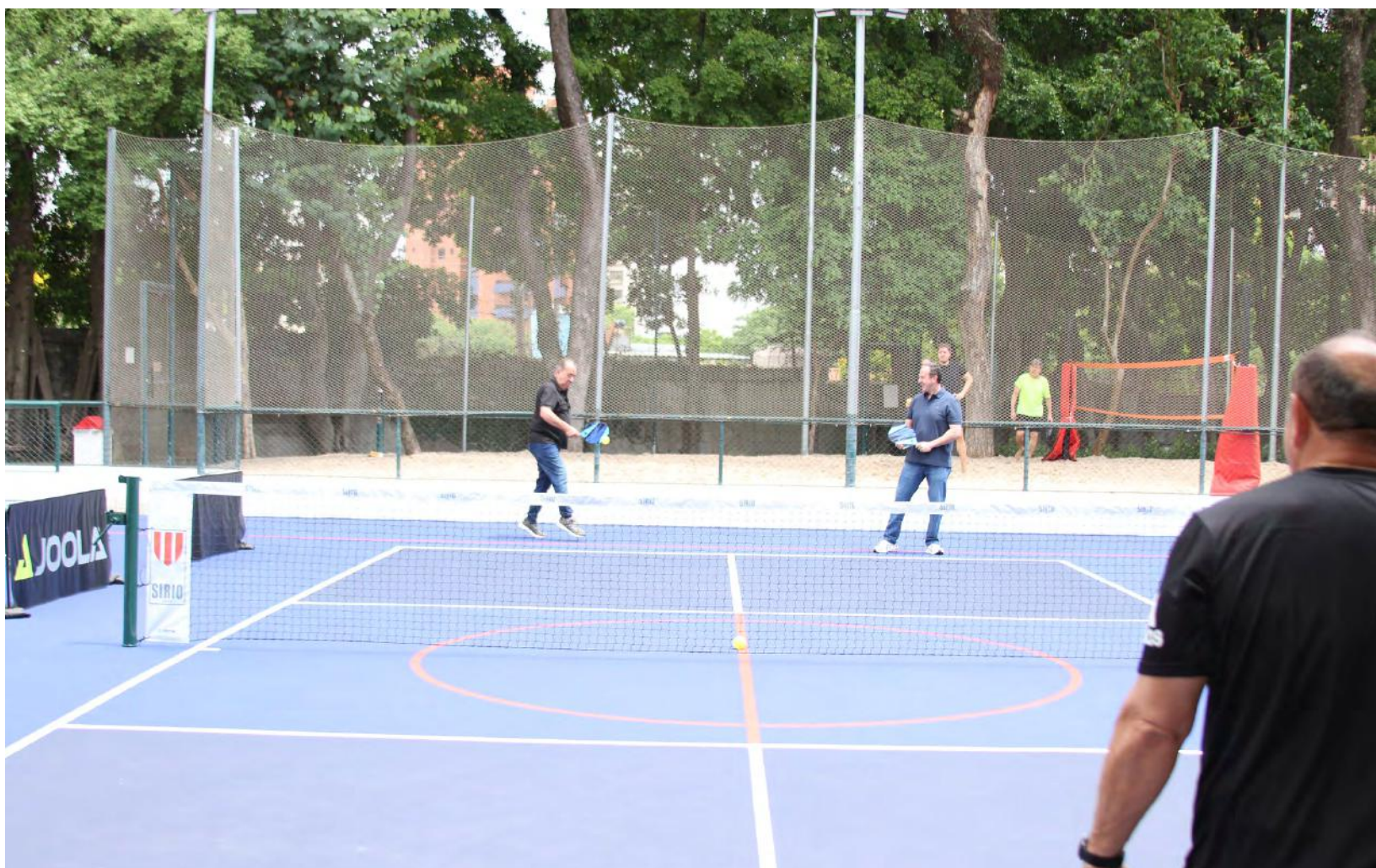
TROCA DO PISO DA QUADRA DO RACHÃO E READEQUAÇÕES NO ENTORNO. ATIVIDADES POLIESPORTIVAS, INCLUINDO PICKLEBALL.
