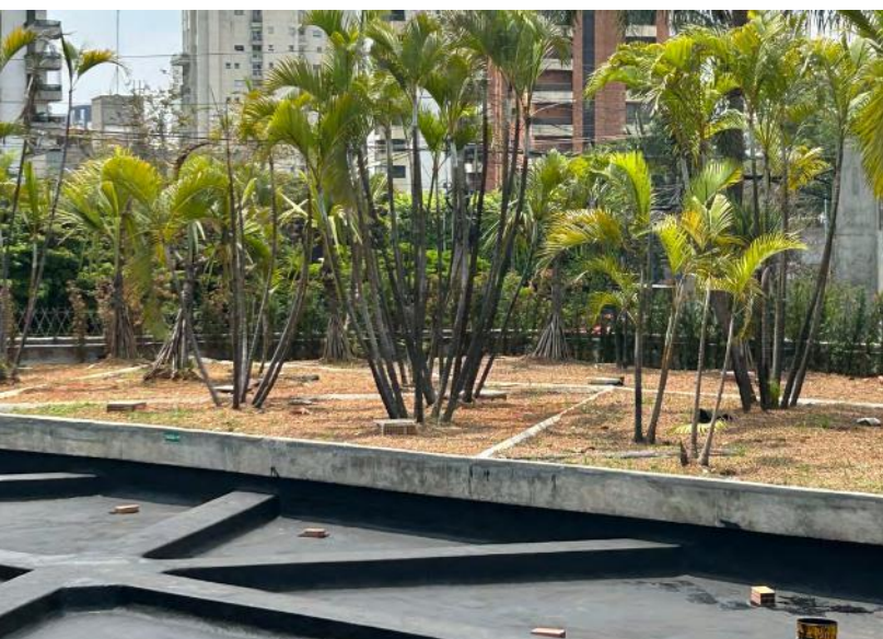
IMPERMEABILIZAÇÃO DO TERRAÇO DO SALÃO NOBRE
