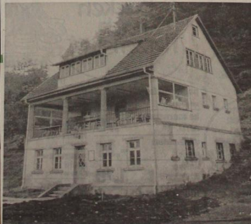
Das alte Klubhaus konnte aufgrund seines schlechten baulichen Zustandes nicht umgebaut werden und wird nach Fertigstellung des neuen Clubhauses abgerissen werden. Fotos: Hildenbrand
