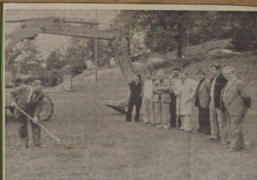
Bürgermeister Rau nahm am Montag den ersten Spatenstich für den Neubau des Clubhauses des Haslacher Sportvereins vor. OT, 23. 10. 1980
