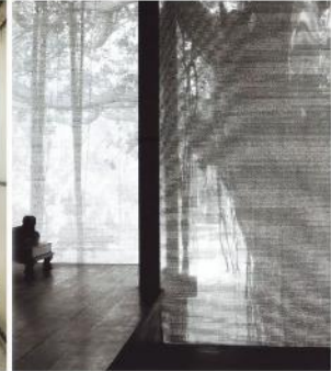
Vách C1 : 2.9 x 2.7m (h x h) Ray trượt âm trần. Treo vào đá bê tông phía trên. Chia 2 tấm 2 bên. Chân rèm may cao 8cm. SL: 3 bộ
