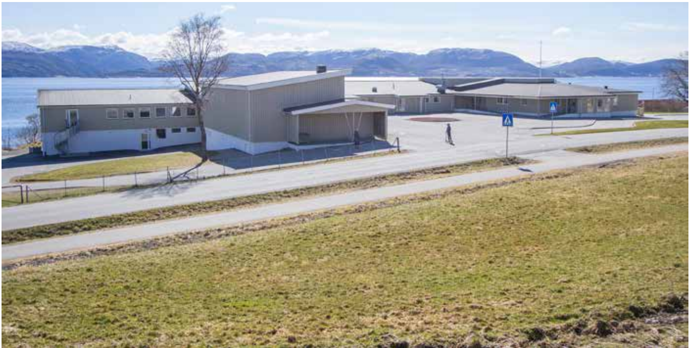
Strand oppvekstsenter 2017, modernisert og oppgradert. Foto: Hitra-Frøya lokalavis
