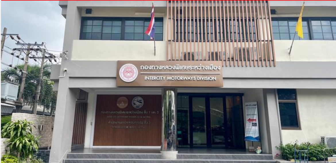
อาคารกองทางหลวงพิเศษระหว่างเมือง (ชั้น 2) กรมทางหลวง พระราม 6
