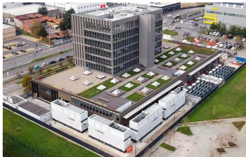
Data center Avalon 3
