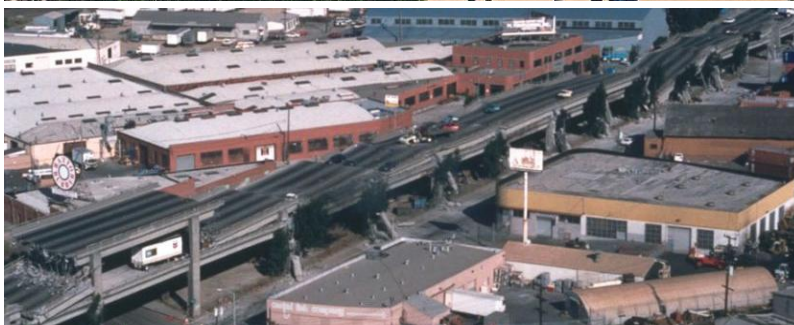
Figura 86: Terremoto de 1989 destruye vía expresa elevada en San Francisco, Estados Unidos. Fuente: Getty Images.
