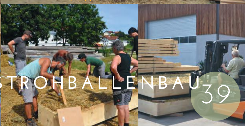
Strohballenhaus, teilweise vorgefertigte Module (Details: strohnatur.at). Strawbalehouse with partly prefab modules in St. Marienkirchen (AT)
