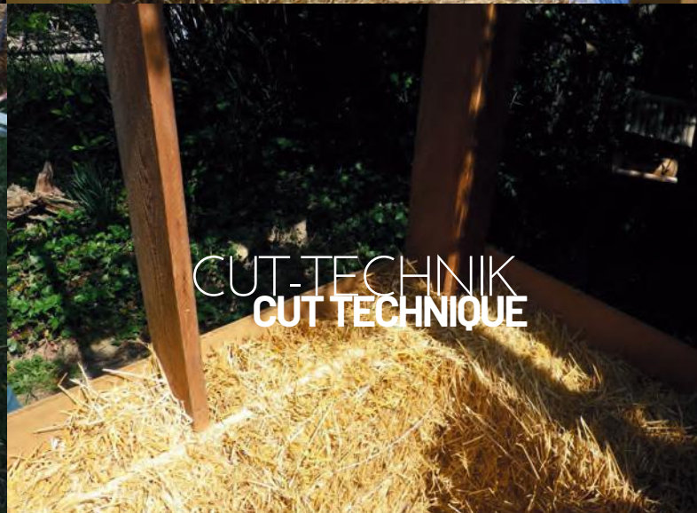
DOPPELSTÄNDERWAND DOUBLE POST CONSTRUCTION
