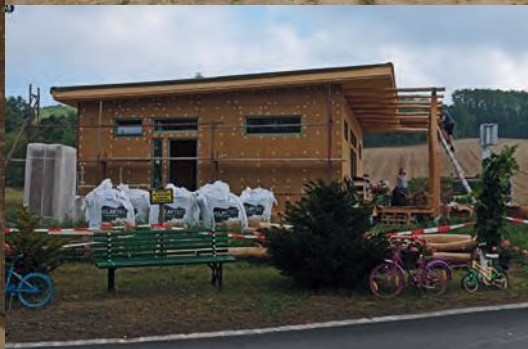
Lorenz Strohbau-Module und VestaEco Strohplatten in Föllim und Klagenfurt Lorenz StrawBale-Panels and Vestaeco StrawBoards in Föllim and Klagenfurt (Details: strohnatur.at).
