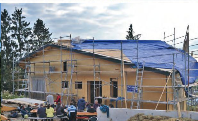
Strohballenhaus, teilweise vorgefertigte Module (Details: strohnatur.at). Strawbalehouse with partly prefab modules in St. Marienkirchen (AT)
