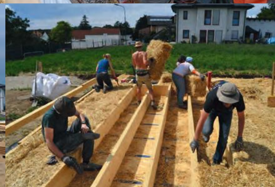
Stroh-Bodenplatte auf Schraubfundament Straw-Baseplate on Screw-Foundation
