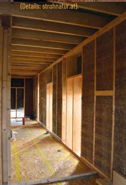
Lorenz Strohbau-Module und VestaEco Strohplatten in Föllim und Klagenfurt Lorenz StrawBale-Panels and Vestaeco StrawBoards in Föllim and Klagenfurt (Details: strohnatur.at).
