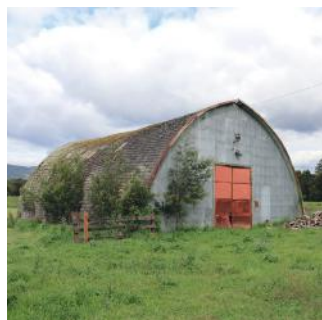
Galpones acceso norte Valdivia (Galpón UACH) Valdivia
