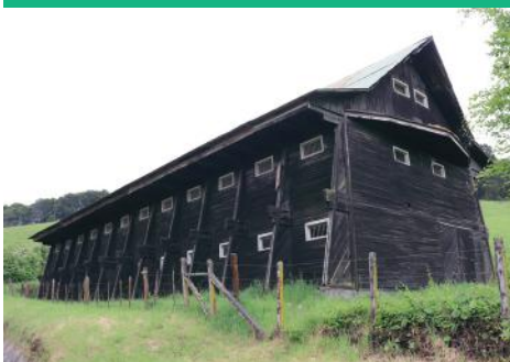
Vista General del Inmueble
