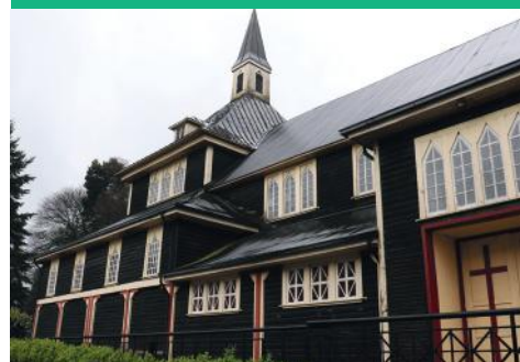
Vista General del Inmueble
