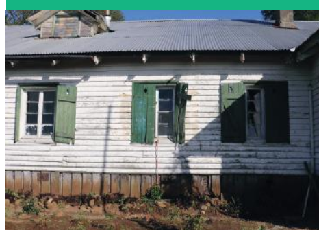
Vista General del Inmueble
