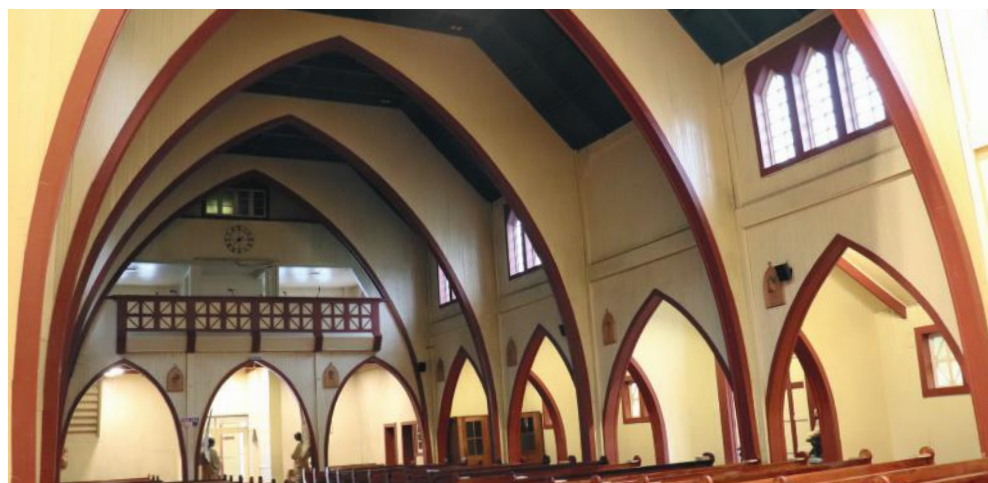
Vista de la nave principal de la iglesia de Panguipulli, construida con el sistema estructural tipo diafragma.
