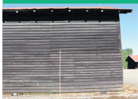
Vista General del Inmueble
