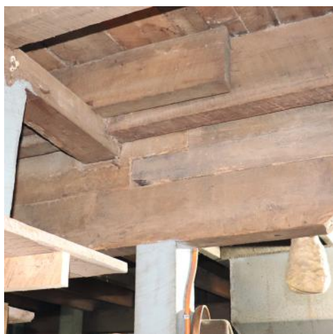
Empalme a media madera en molino San Miguel y encuentro a media madera de tornapunta con viga en molino Crucero.
