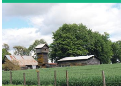
Vista General del Inmueble
