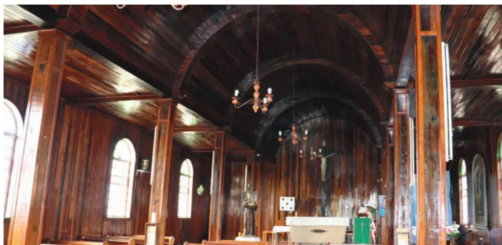
Vista de falsa bóveda de cañón en iglesia de la Misión de Pelchuquín, comuna de San José de la Mariquina.
