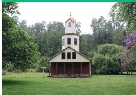
Vista General del Inmueble
