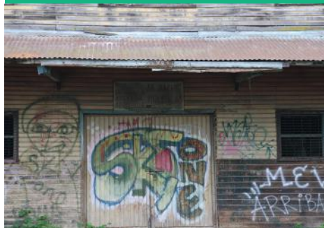
Vista General del Inmueble
