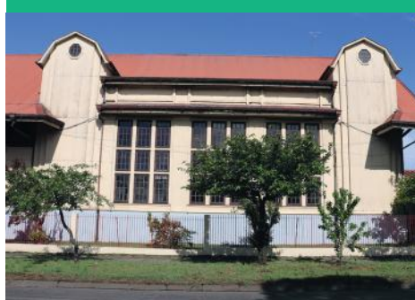
Vista General del Inmueble
