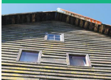
Vista General del Inmueble
