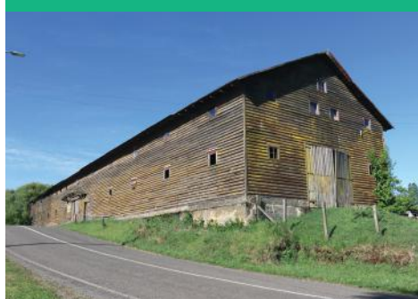
Vista General del Inmueble
