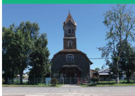
Vista General del Inmueble
