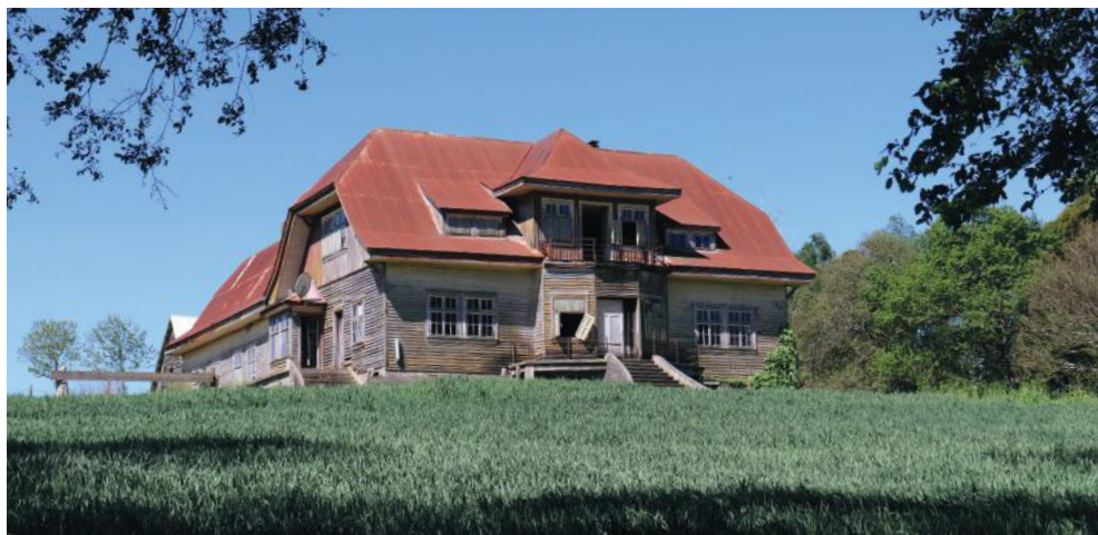
Casa principal del fundo Nassa, comuna de Paillaco. Destaca cubierta con mansarda y ventanas abuhardilladas.
