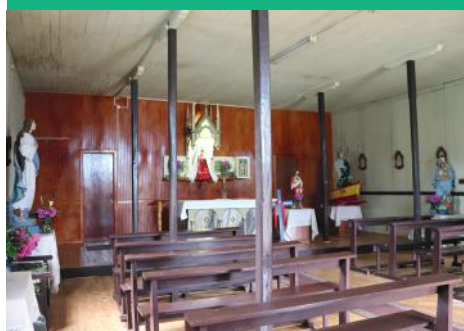
Vista General del Inmueble
