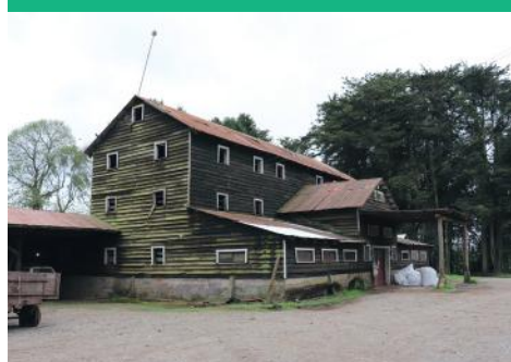
Vista General del Inmueble
