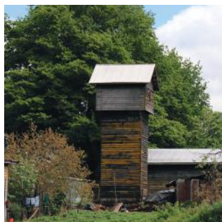
Depósito de agua sector Río Bueno Río Bueno
