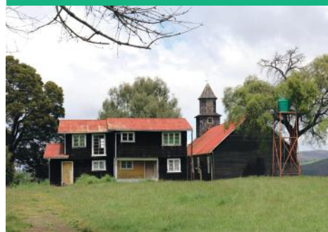
Vista General del Inmueble
