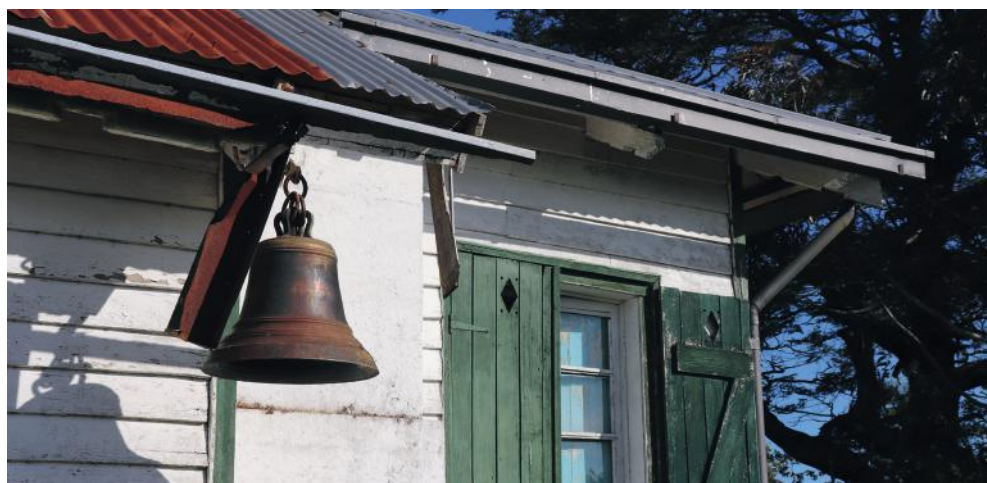
Detalle campana ex escuela situada en la casa principal del fundo Loncopán, comuna de Futrono.
