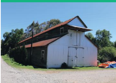
Vista General del Inmueble
