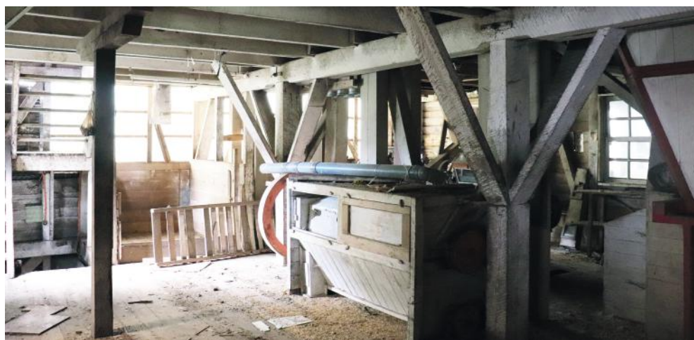
Vista interior de molino harinero en sector Crucero, comuna de Río Bueno.
