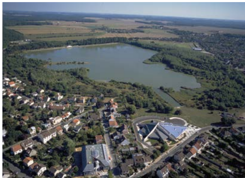
Photographie aérienne du village de La Verrière avec au premier plan l'Hôtel de ville et le Scarabée, 2011.
