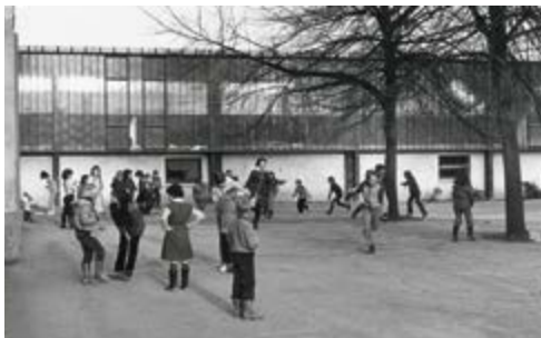
Gymnase « cloisonné » servant d'école provisoire avant d'abriter le centre culturel Cocteau.
