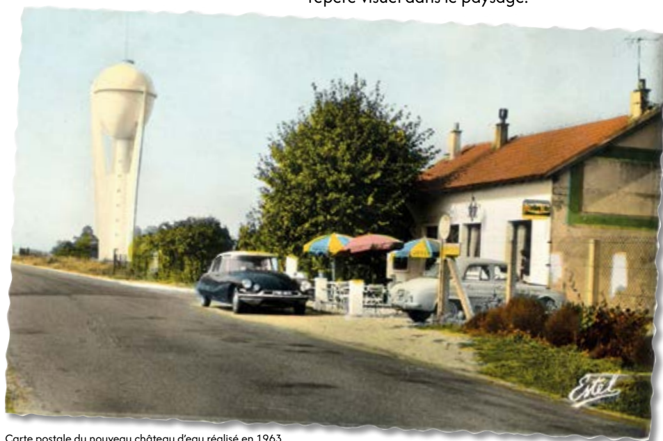
Carte postale du nouveau château d'eau réalisé en 1963 par l'architecte Marcel Astorg à proximité du bar-crêperie Le Vert-Galant.
