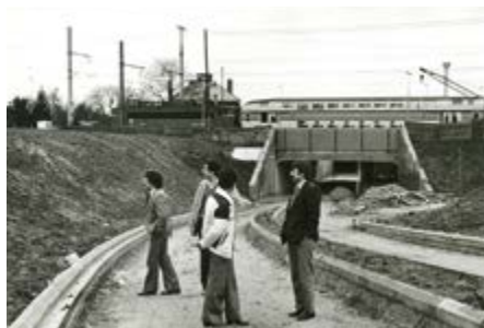
Le maire Gérard Lamidey avec ses adjoints lors d'une visite de chantier du passage souterrain de la gare, 1979.
