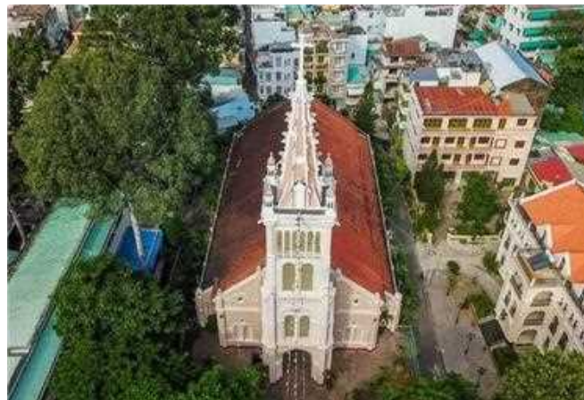
Toàn cảnh Nhà Thờ Chợ Quán hiện nay vẫn giữ được nét kiến trúc xưa
