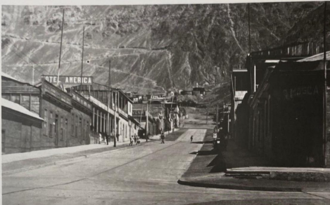
Calle Serrano. Construcciones antiguas y el Hotel América, construido en 1885 siendo su primer dueño don Juan Radic.
