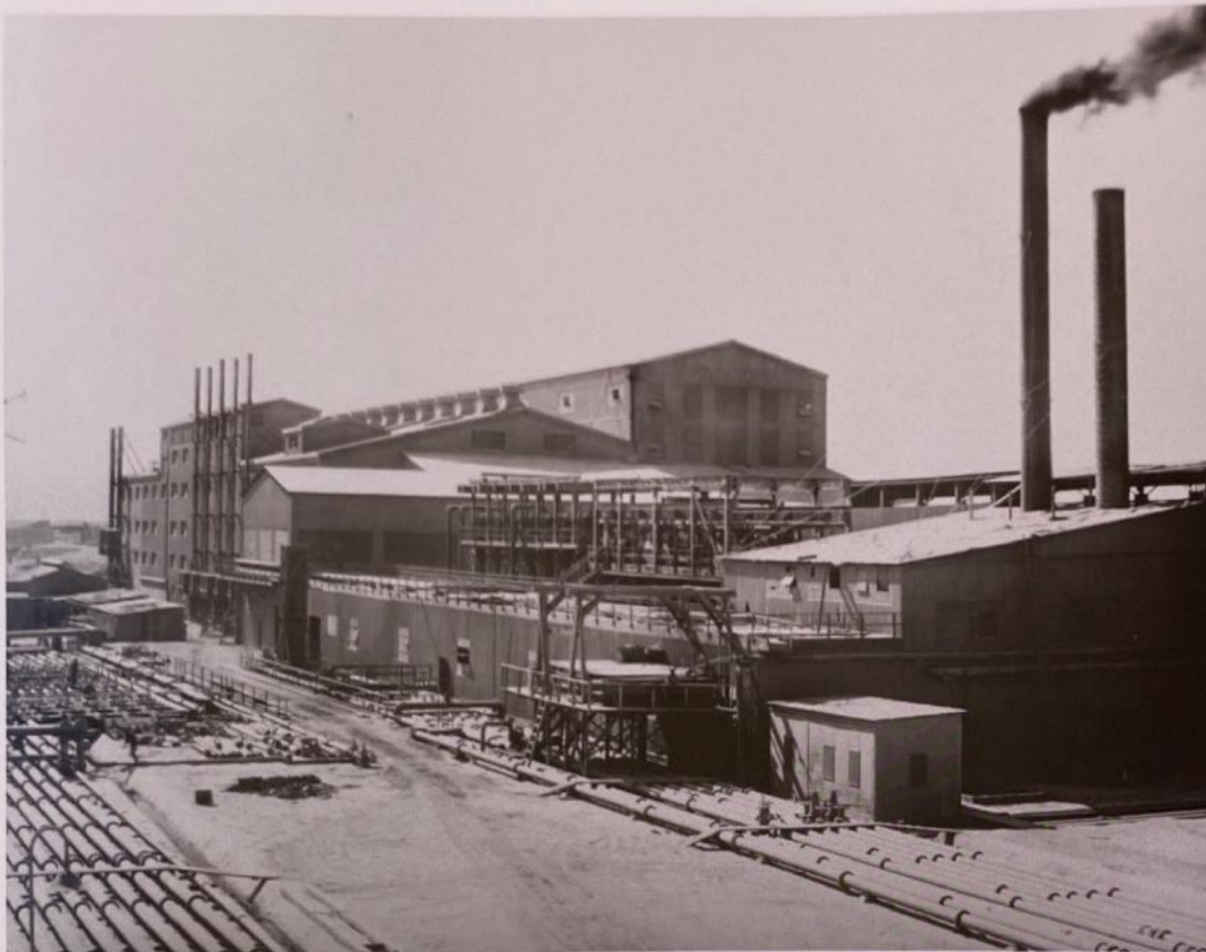
Vista general de la casa de fuerza y de la casa de bombas.
