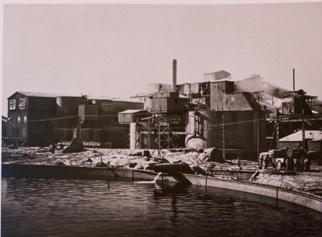
Estanque de agua para lixiviar y construcciones que alojan los Molinos.
