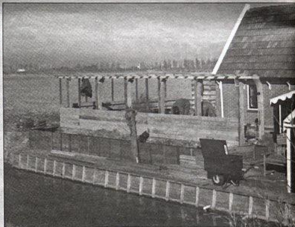
Naast specialisatie in grondwerk nu ook beschoeiingswerk
