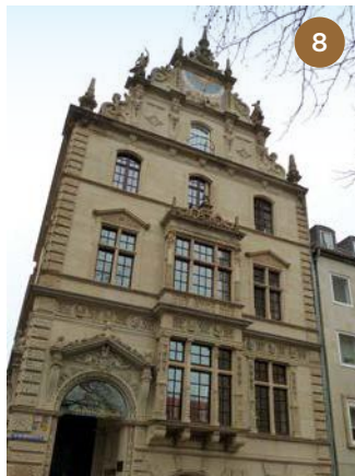
Bankhaus Löbbecke, Braunschweig
