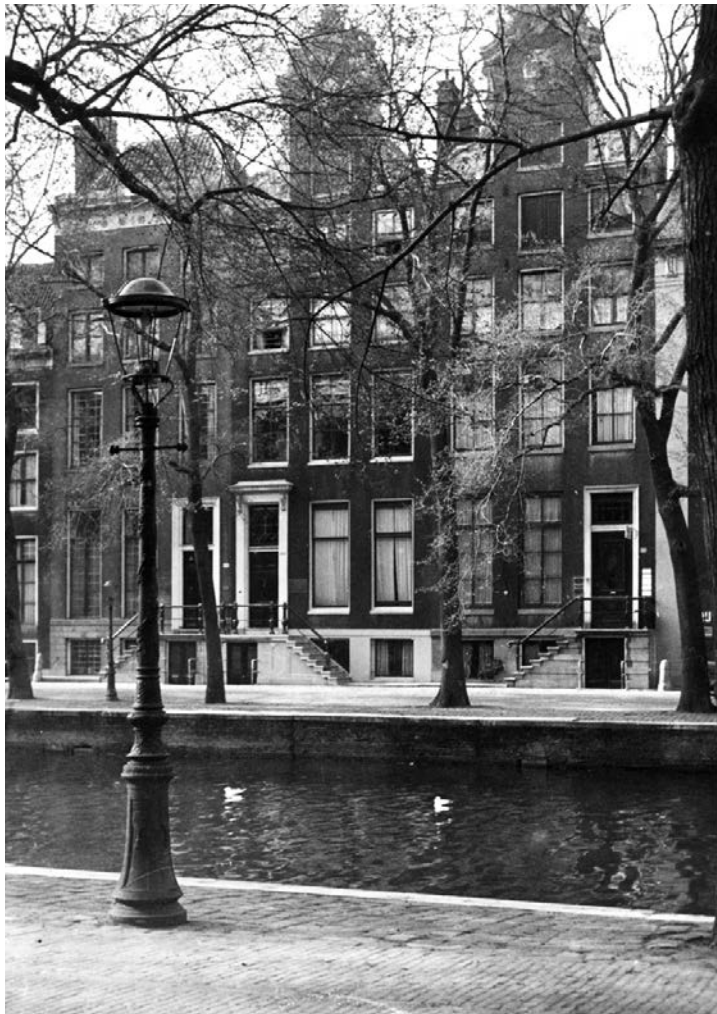
Das Gebäude von Warburg & Co. KG in Amsterdam, 1929
