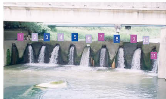
可調節水量的十一孔水門
