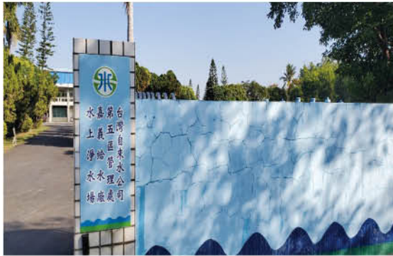
■ 嘉義給水廠水上淨水場
