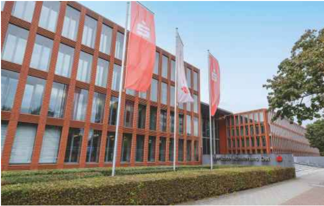
Zentrale der Sparkasse Münsterland Ost in Münster.
