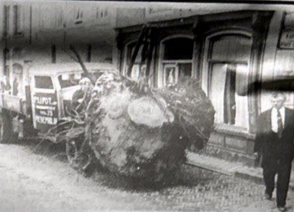
De plaatselijke transportondernemer J.J. Pot werd ook ingeschakeld bij het werk op de Nieuwstraat. De laatste resten van de bomen konden worden afgevoerd. Een hele hijs overigens. De man rechts is de uitvoerder van de NRM. Bakker De Git en lunchroom 'Sico' zijn dan al vertrouwde zaken. In het pand hiernaast vervaardigde Hendrik Idema ooit zijn meubels en ook visboer Van Doorn bracht hier ooit zijn haringen en andere lekkernijen aan de man. Een mooi pand met de winkeldeur in het midden. Later werd dit pand gekocht en verbouwd door Piet Blokker en kwam de firma Blokker definitief op de Nieuwstraat. Rechts is nog het bord van kapper P.H.J. Feijze (Fikkie) te zien.
