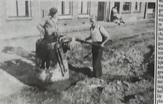
■ Een vooroorlogse trilmachine moest er een vaste laag van maken, daarna kon men beginnen met het straatwerk. En liep zat toen al voor de winkel.
