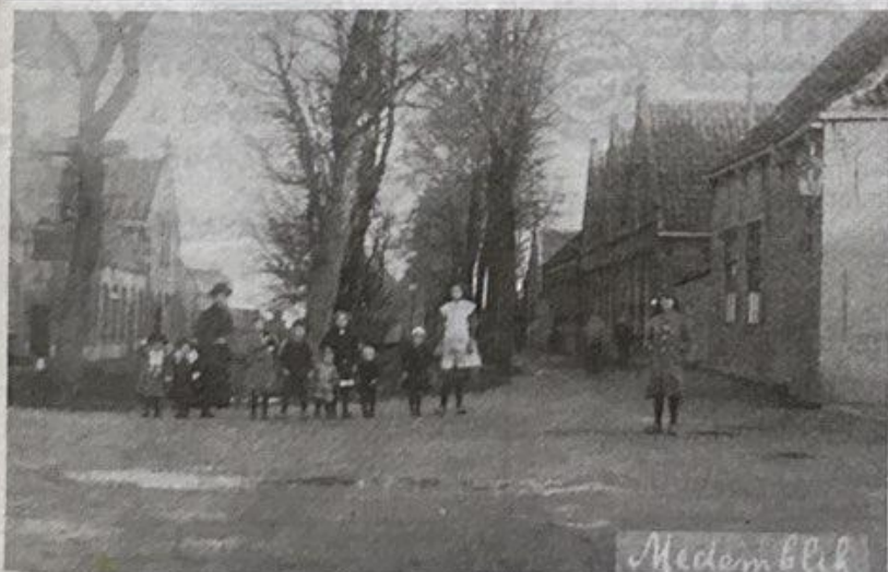
De Oude Haven anno 1920. Hier stond het ouderlijk huis met aan de overkant de gasfabriek.
