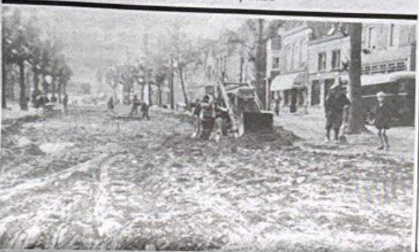
Een omgeploegde Nieuwstraat.
