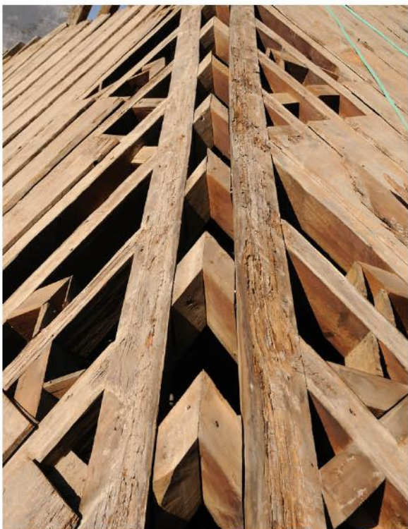
Fig. 33: Limas moamares. Se observa que a algunos de los tajeles que completan el lazo se les han añadido tablas en sus lados para parecer una pieza maciza. Imagen cedida por Luis Anselmo Ibáñez Calero, arquitecto responsable del proyecto de restauración del año 2009.
