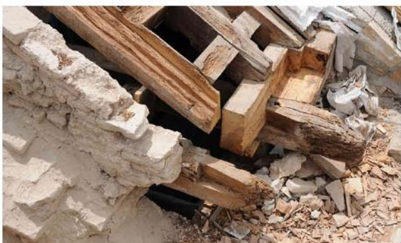
Fig. 31: Encuentro entre tirante y estribo mediante una cola de milano. Imagen cedida por Luis Anselmo Ibáñez Calero, arquitecto responsable del proyecto de restauración del año 2009.
