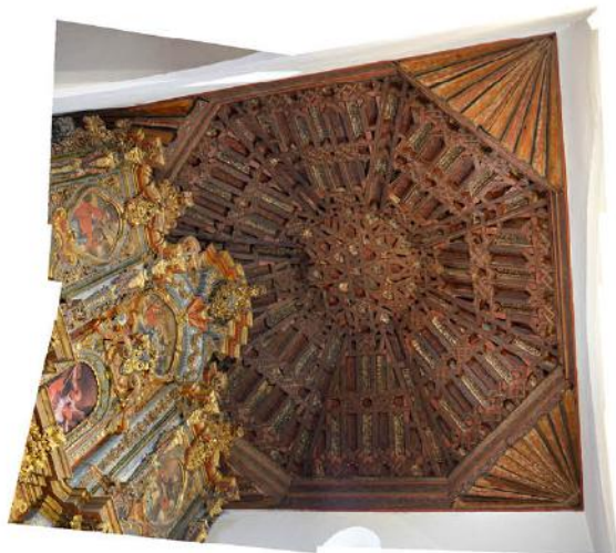
Fig. 9: Armadura ochavada sobre pechinas y retablo de Blas Moreno.
