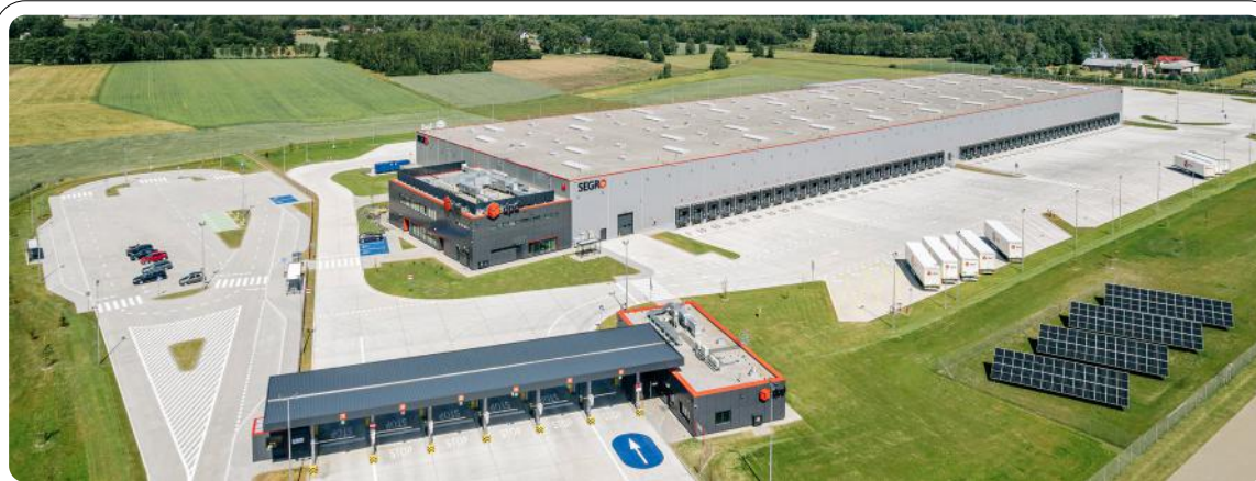
Fot. 3. Hub logistyczny DPD w SEGRO Logistics Park Stryków koło Łodzi (fot. SEGRO)
