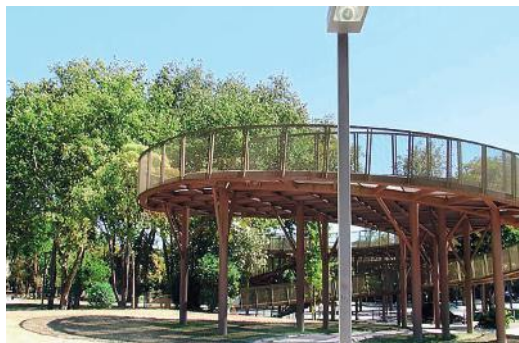
Imagem 12 – Estrutura em metal existente na Avenida Artur Ravara [i12]
