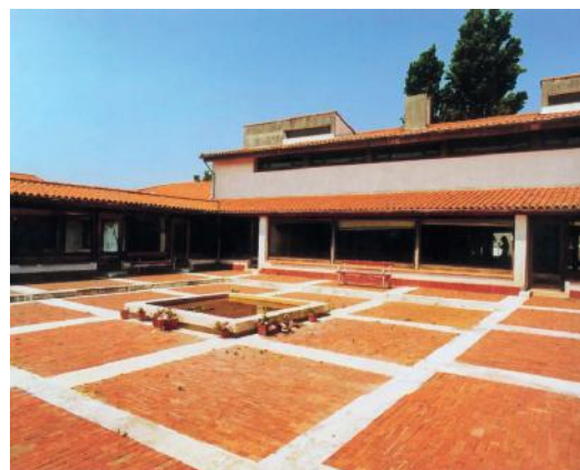
Imagem 8 – Zona aberta interior do “Conservatório de Música” de Aveiro [i8]
