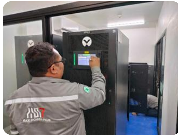
การบำรุงรักษาระบบสำรองไฟ (UPS) ประจำอาคาร
