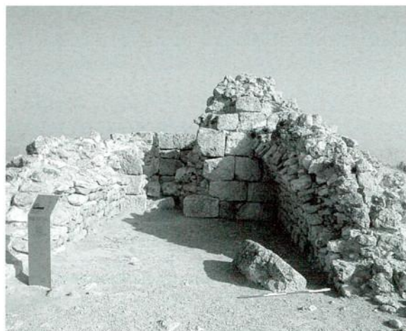
Figura 3. La torre principal del castell medieval d'Olèrdola es va construir aprofitant una torre antiga d'origen romà. Arxiu MAC-Olèrdola (MO.OL.1097).
