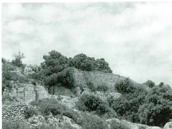
Figura 7. La muralla medieval del costat de llevant de la plataforma del castell feia uns 90 centímetres d'amplada i, alhora que servia de defensa, també va ser utilitzada com a paret posterior d'alguns habitatges. Arxiu MAC-Olèrdola (MO.OL.906).
