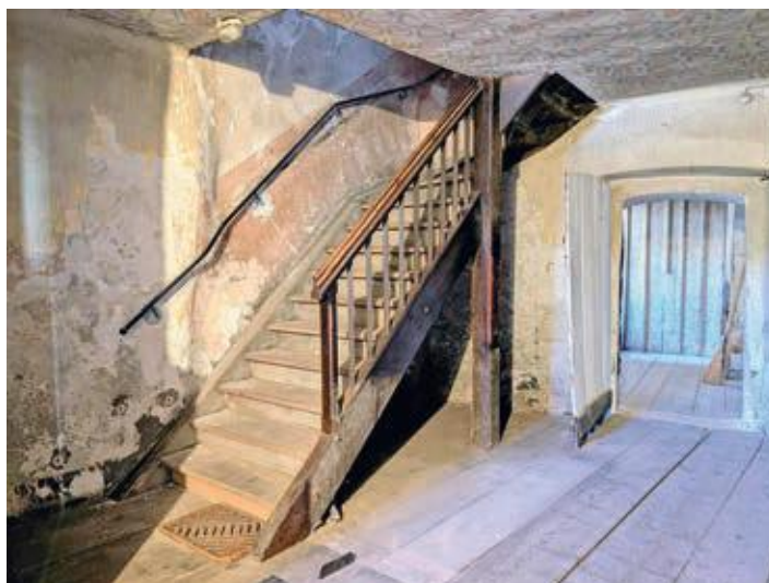
Groß, geräumig und außerordentlich gut erhalten überdauerte das älteste Haus von Lienz die Jahrhunderte.
