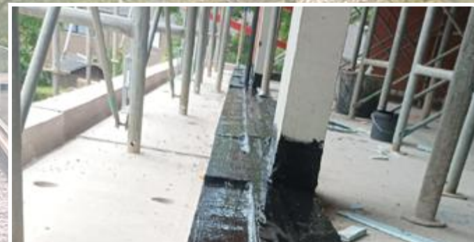
PARVEKKEEN LIITOKSEN VEDENERISTYS SITKO LIQUID SEAL EVO:LLA
