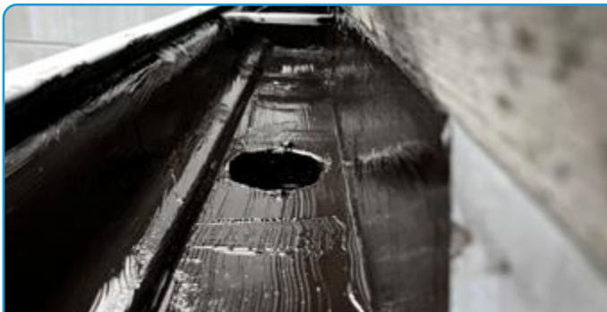
ELEMENTTISEINIEN LIITOSTEN VEDENERISTYS
