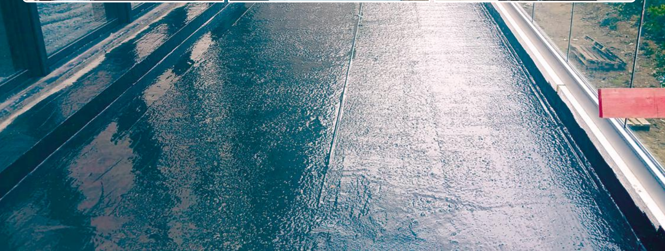
PARVEKKEEN VEDENERISTYS SITKO LIQUID SEAL EVO:LLA
