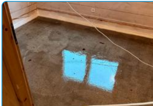
PINNOITUS BETONIN PÄÄLLE
