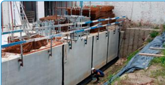
ELEMENTTISEINIEN LIITOSTEN VEDENERISTYS
