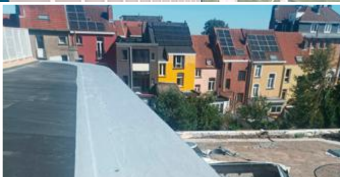
PARVEKKEEN VEDENERISTYS SITKO LIQUID SEAL EVO:LLA
