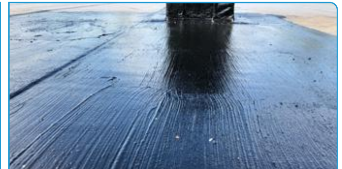
ELEMENTTISEINIEN LIITOSTEN VEDENERISTYS
