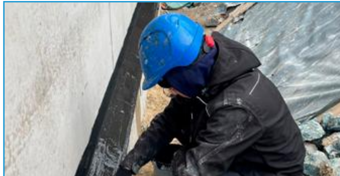
ELEMENTTISEINIEN LIITOSTEN VEDENERISTYS
