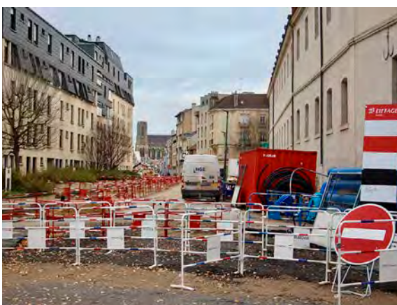
Pas épargné par les travaux de la voie des Sacres, le quartier Saint-Remi va connaître un autre chantier d'importance. © Archives l'Hebdo du Vendredi
