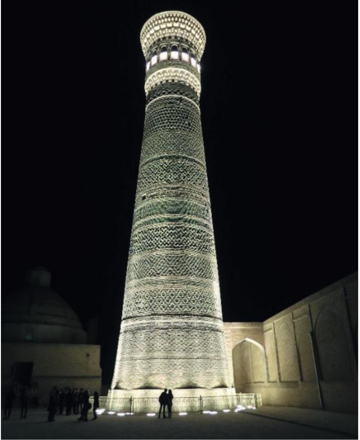
Foto-13 Kalon Minaresi
