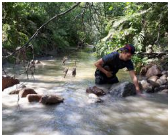
Membre de l'équipe en train de placer des roches pour réaliser le seuil. (©Ma grosse truite chérie)
