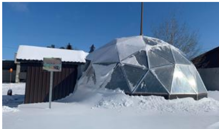
Serre solaire passive du Cégep de St-Félicien vu de l'extérieur. (© Mégan Diotte)
