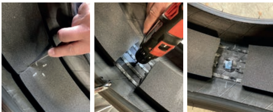
Det støjdæmpende materiale fjernes og reparationsområdet klargøres til permanent reparation.
