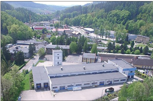
Nowa Ruda, Górnicza Str. Fertigungsstandort für Outdoorschränke
