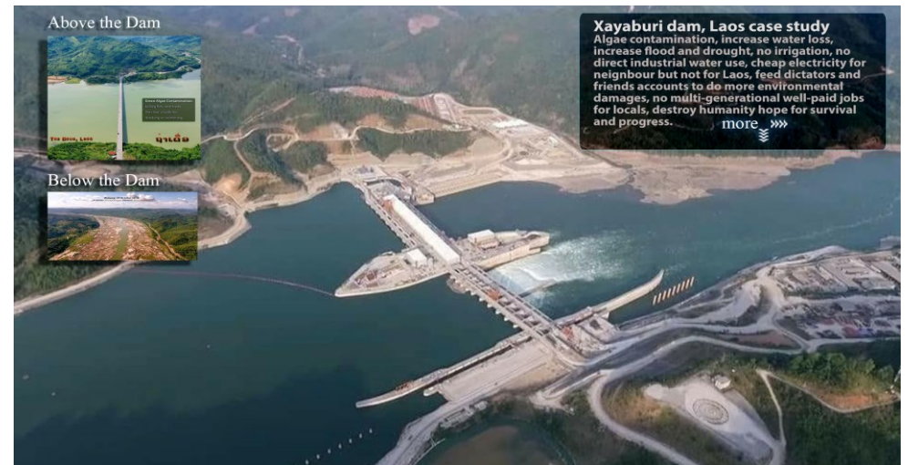
Xayaburi Dam, Laos / ເຂື່ອນໄຊຍະບູລີ
