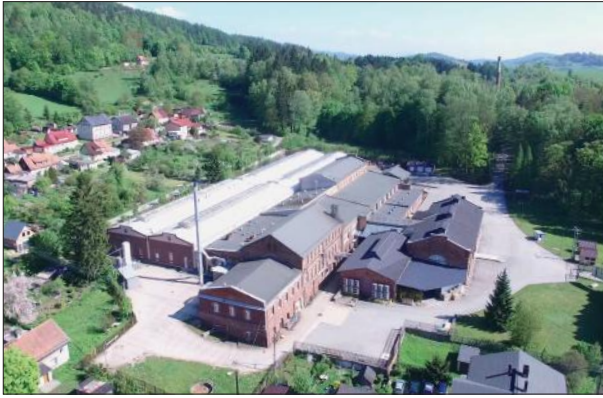
Przygórze Biuro Zarządu ZPAS S.A., administracja i zakład produkcji projektowej
