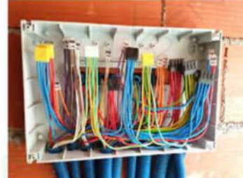
Extinction d'incendie pour boîte dérivation
