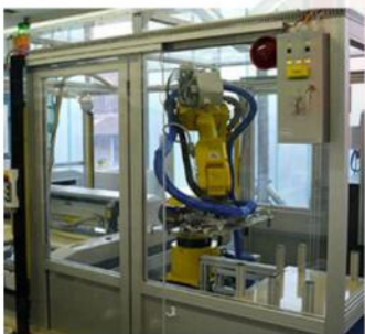
Extinction d'incendie pour les équipements robotique fermée
