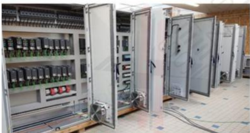
Extinction d'incendie pour armoire électrique
