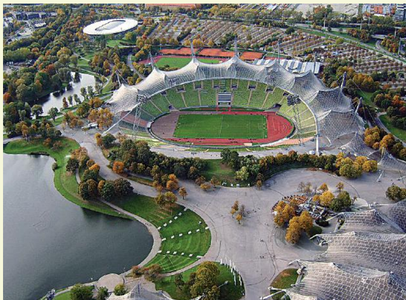
Frei Otto arkitektoak diseinatu zuen Municheko Estadio Olinpikoa. Horretarako, xaboi-anpulu betetako bainuontzi batean murgiltzen zituen makilak eta lokarriak, eta haiei itsasten zitzaizkien anpuletatik abiatuta definitu zuen egitura. ARG.: ARAD MOJTAHEDI/DOMEINU PUBLIKOA.
