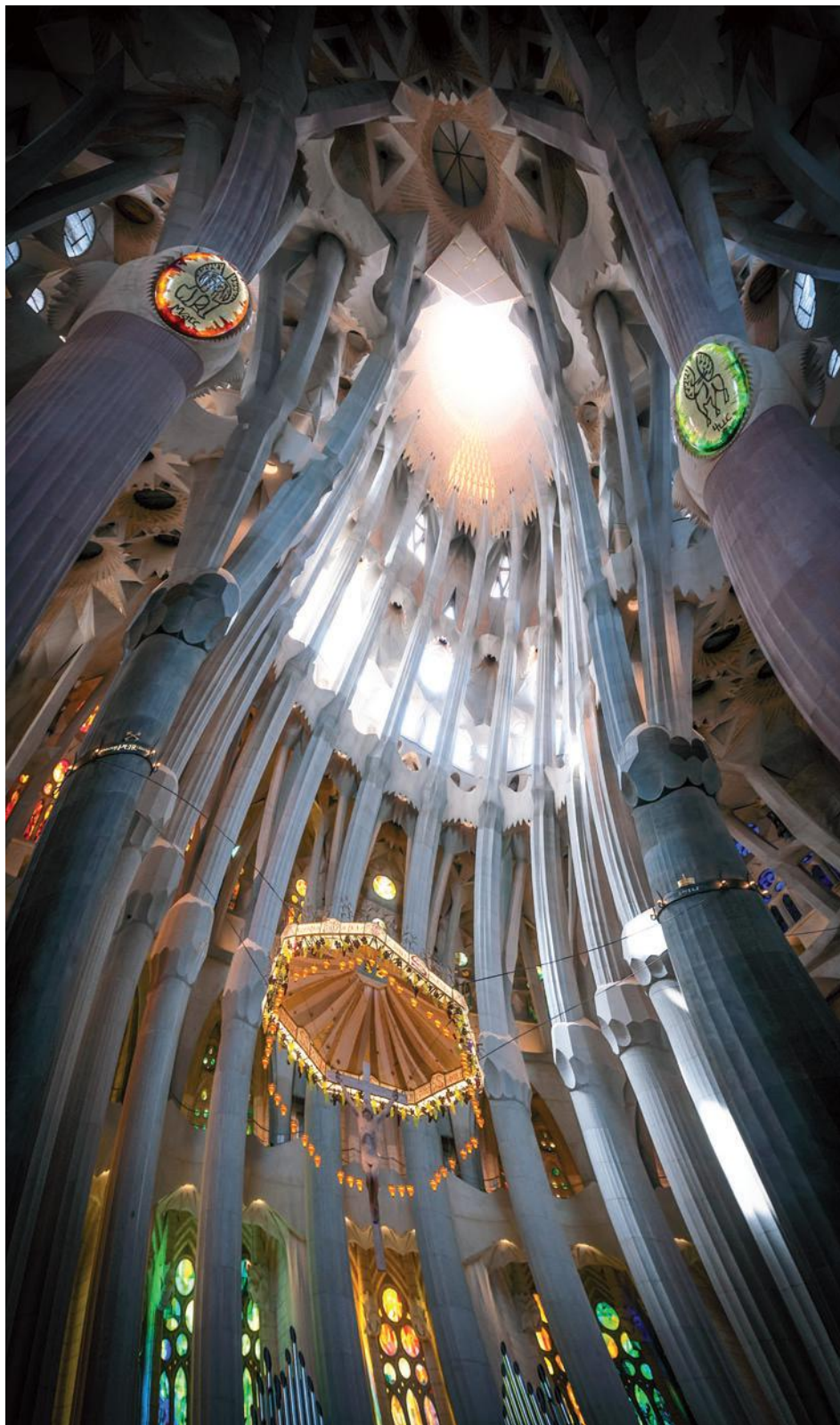
Familia Santuaren argizulo bat barrualdetik ikusita. Horrelako egituretan, Gaudík paraboloidak, hiperboloidak eta beste forma geometriko asko erabiltzen zituen, forma ikusgarriak eraikitzeko. ARG.: © KONSTANTIN YOLSHIN/123RF.
