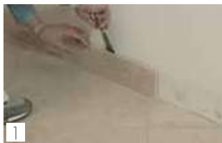
1 Eliminare il battiscopa Remove skirting
