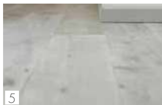
5 La superficie risulterà perfettamente planare The finished floor will be perfectly flat
