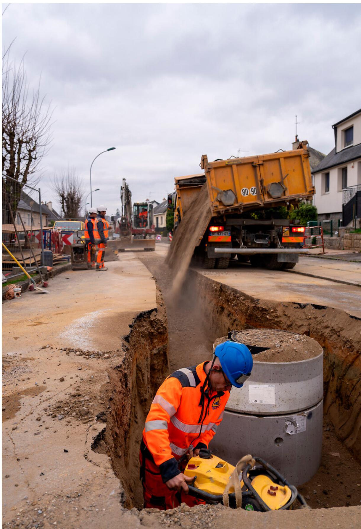
Remplacement de la canalisation des eaux usées : avenue Beauséjour à Mordelles © photo : Arnaud Loubry - Rennes Ville et Métropole
