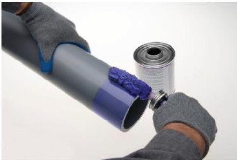
Apply primer to OD of pipe
