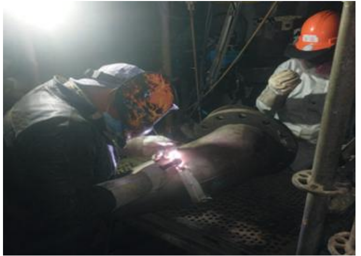
MODIFICACION PIPING LINEA FINAL VAPOR BAJA PRESION AREA DIGESTORES ARAUCO PLANTA VALDIVIA
