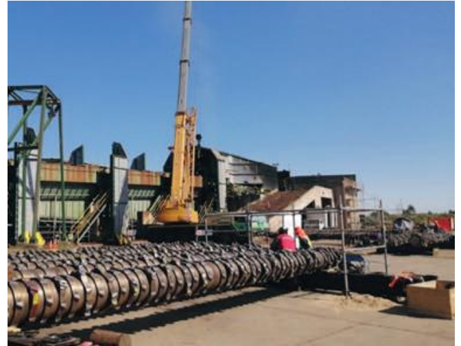
DESMONTAJE DE ROTORES
