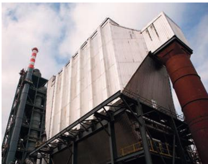
PRECIPITADORES ELECTROESTATICOS
