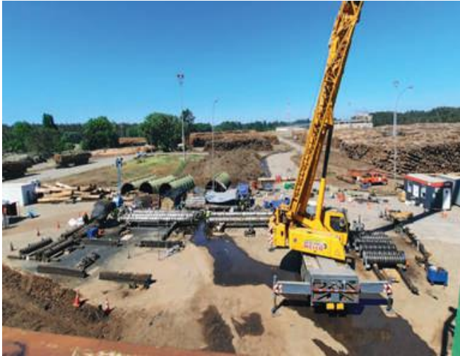
DESMONTAJE DE ROTORES
