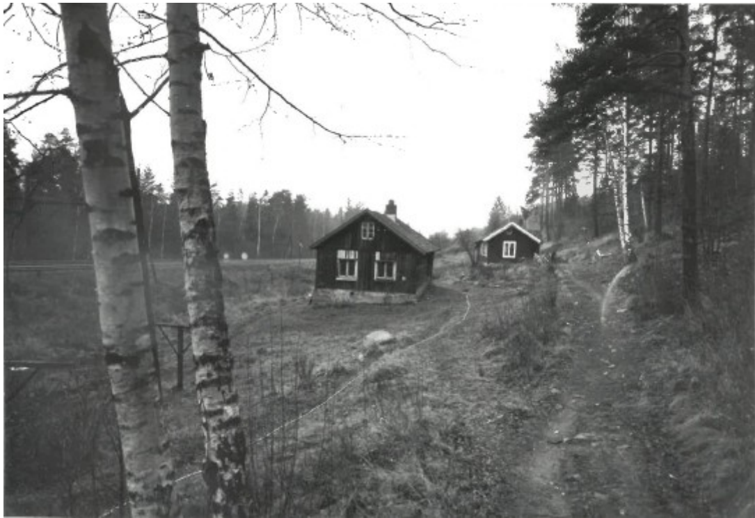
De to bolighusene i Lia. Det nederste huset ble revet kort tid etter at bildet ble tatt. Det øverste ble stående et par år til. Bildet er tatt mot nord. Foto: Byantikvaren i Oslo, 3. november 1972
