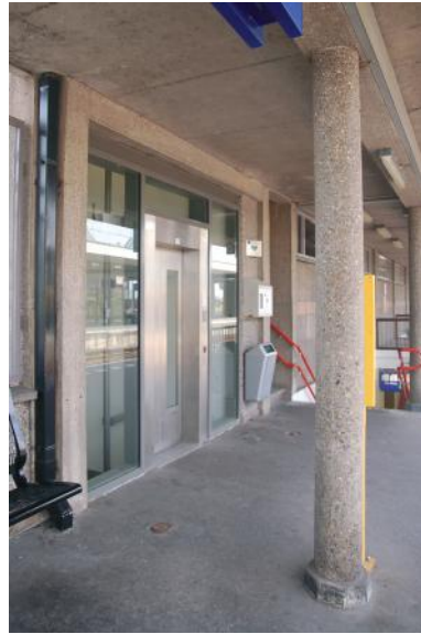
kolommen op perron 1 met hun nog oorspronkelijke basement
