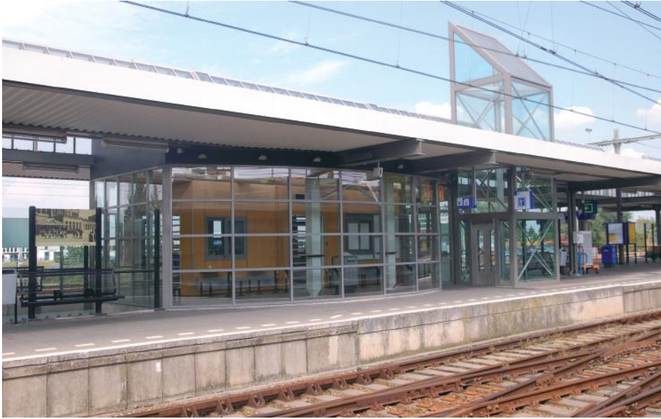
perronoverkapping en gebouw, Rob Steenhuis, ca. 1995
