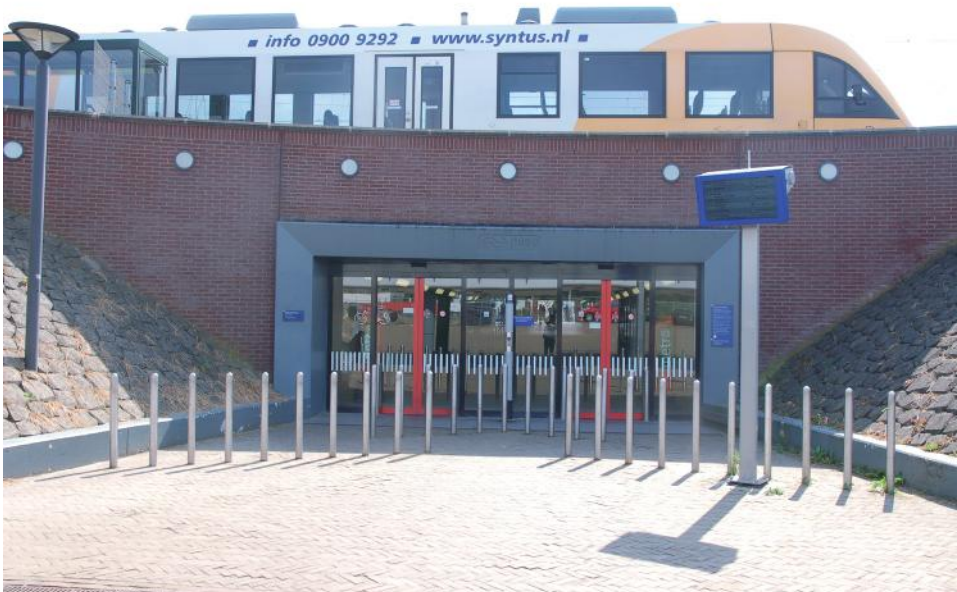
entree perrontunnel noordzijde
