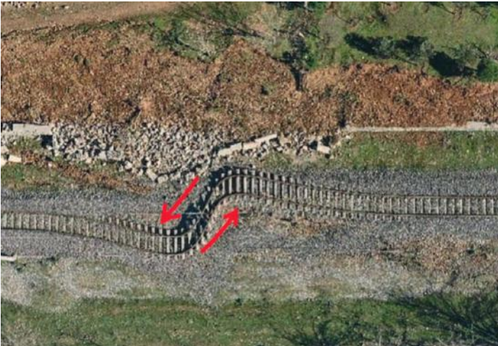
Şekil-4 Deprem bölgesindeki tren raylarında meydana gelen fay atımı
