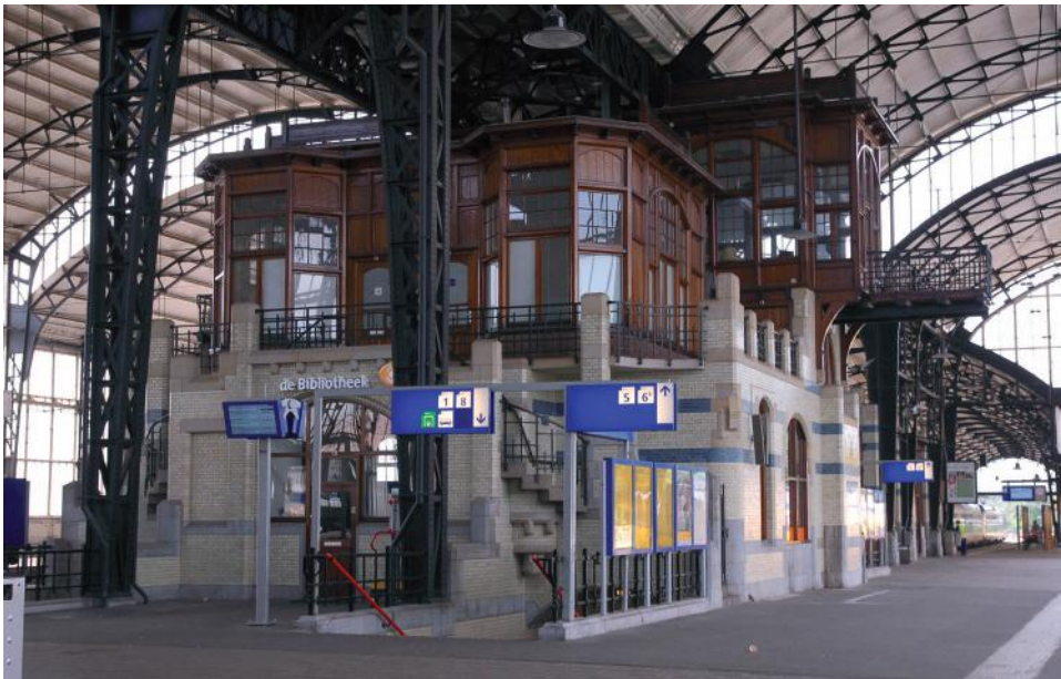
gebouw D, Seinhuus
