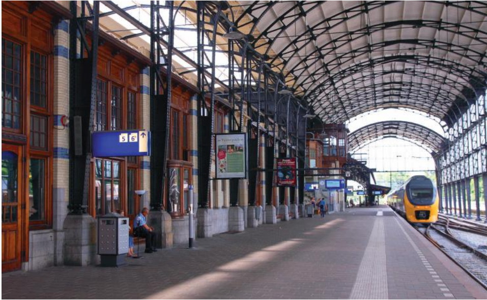
De kapconstructie, ontworpen door H.W.M. Werker
