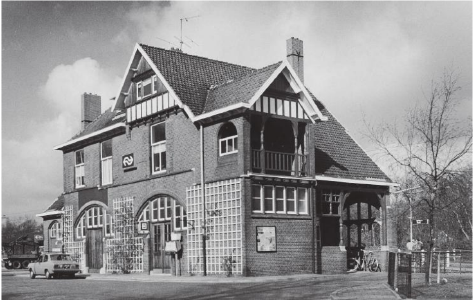
Station Santpoort Zuid, 1898
