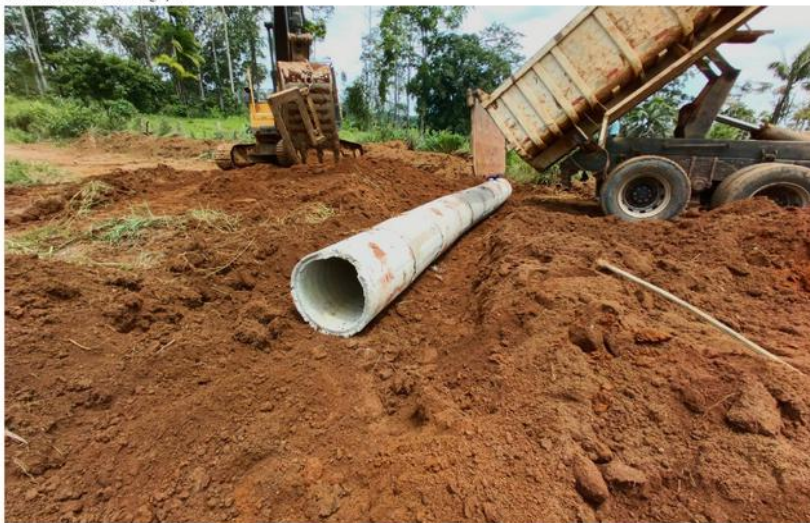
Os serviços foram realizados no trecho entre os km 2 e 10 da via, com recursos e maquinários da prefeitura
