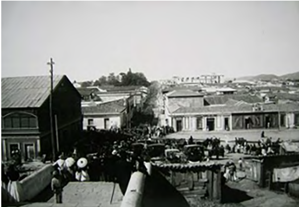
Ilustración 26. Campamento frente al templo de El Calvario, en la 18 calle y antigua Calle Real, en donde fueron surgiendo lugares de exhibición del cine. A la izquierda, la desaparecida Placita Quemada, a la derecha un campamento de desplazados. Museo Nacional de Historia.
