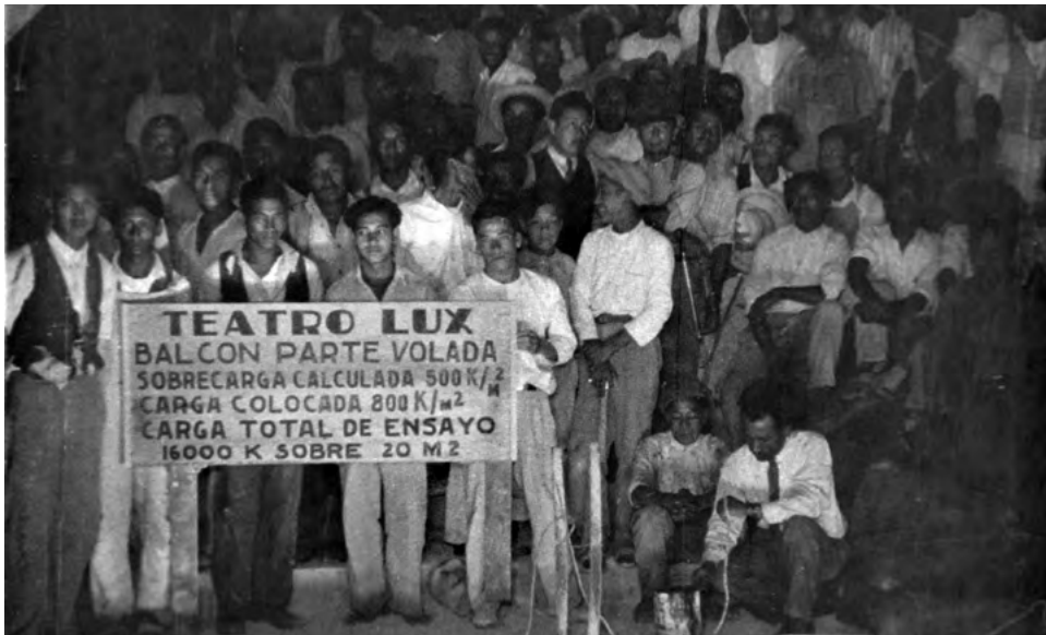
Ilustración 41. Obreros de la construcción en la fase final de la construcción del teatro Lux, junio de 1935. Fotograma de noticiero de la Tipografía Nacional depositado en la Cinemateca Universitaria "Enrique Torres". Archivo de la Imagen IIHAA, digitalización a cargo de Edgar Barillas.
