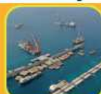
Projet GTA avec Eiffage Génie Civil Marine
