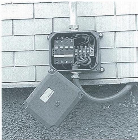
Überspannungsableiter bei der Hauseinführung.
