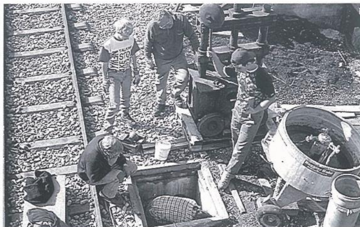
Vorbereitungsarbeiten zum Kabelzug in einem Schacht. Auch Zuschauen kann schön sein.
