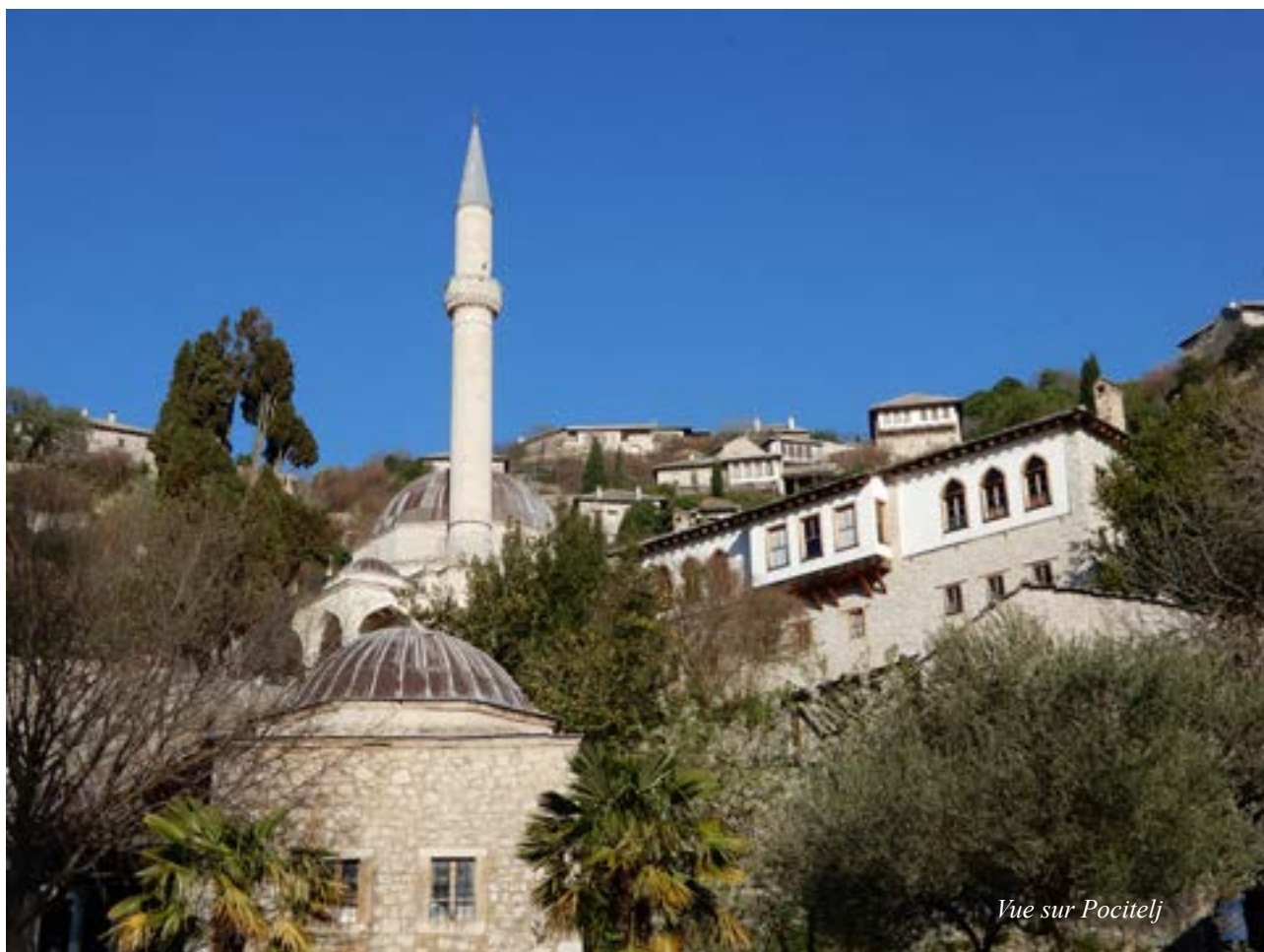
Le Stare Most à Mostar
