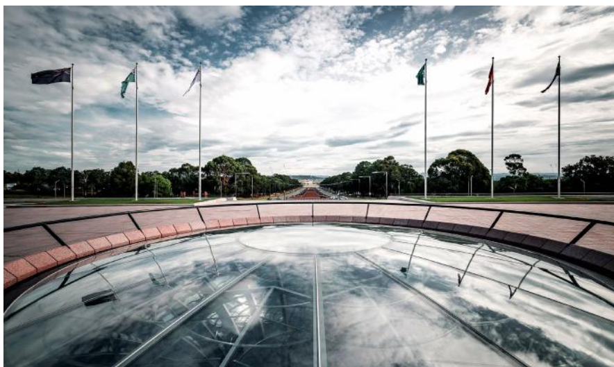
El elemento más destacado de la renovación es EL ÓCULO, una claraboya circular que conforma una estructura de acero y vidrio de gran escala, concebida como una inversión geométrica de la cúpula bizantina original.
