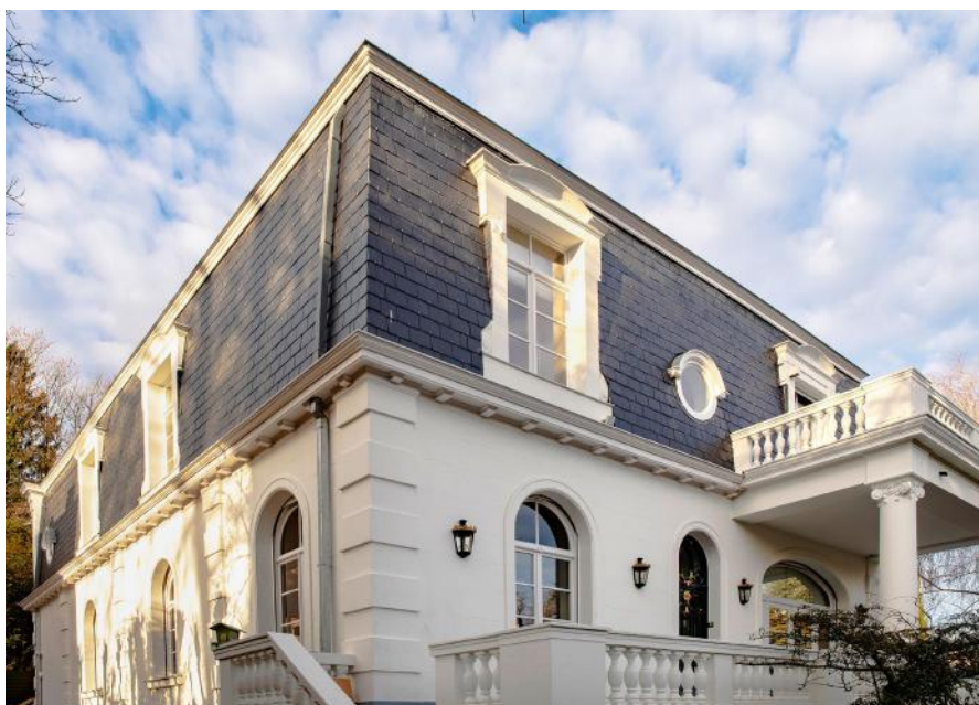
En la renovación de la villa de estilo Art Nouveau se sustituyeron las ventanas originales por 30 unidades fabricadas con vidrio aislante al vacío FINEO de AGC.
